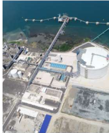
파나마 콜론 복합발전소&LNG 터미널
